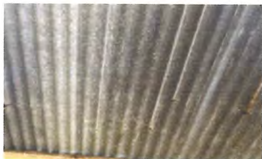
Foto 5: CUBIERTA DE LAMINA
