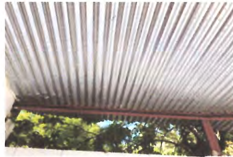
Foto 4: CUBIERTA DE LAMINA
