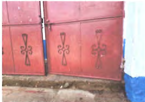
Foto 3: MANTENIMIENTO A PORTONES
