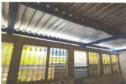
Foto 3: VENTANAS Sustrucción de ventanas; sistema de apertura: Corredizas, Perfiles color blanco estandar, Material del marco: PVC. Material de la ventana: Vidrio, sellado perimetral. Aula al fondo
