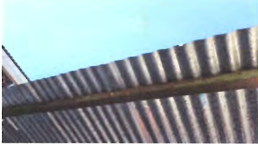
Foto1: ESTRUCTURA DE TECHO
