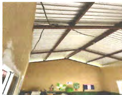
Foto 6: REPARACIÓN SISTEMA ELECTRICO. Reparación de instalaciones eléctricas, cableado distribuido a tomas de corriente y circuitos de iluminación.
